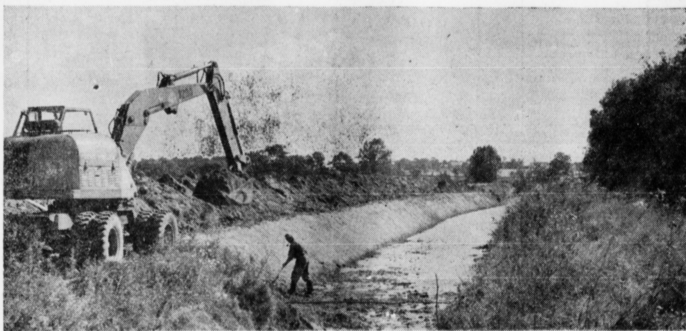
Gravemaskinen i arbejde ved åløbet. Bemærk åløbet før og efter udgravningen.
